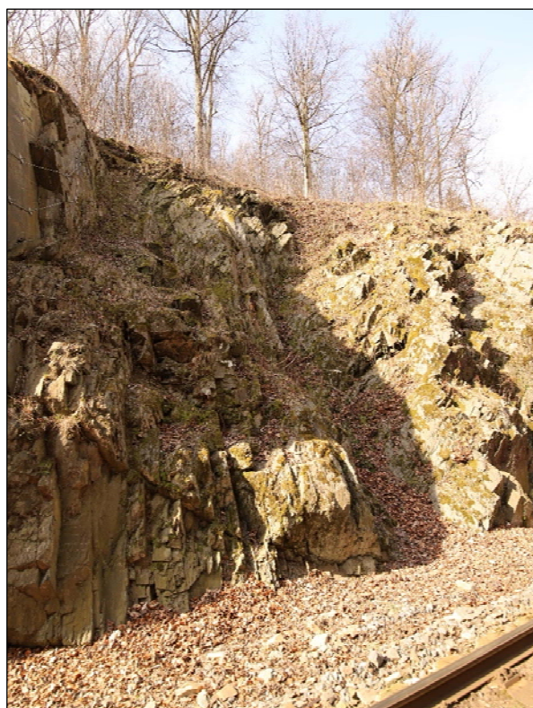
Obrázek 167: na levé straně v km 22,960 – 22,970 je vytvořen vlivem tekoucí vody z horních partií žlab, masiv svou geologií podléhá vodní erozi a místy je charakteru štěrku
