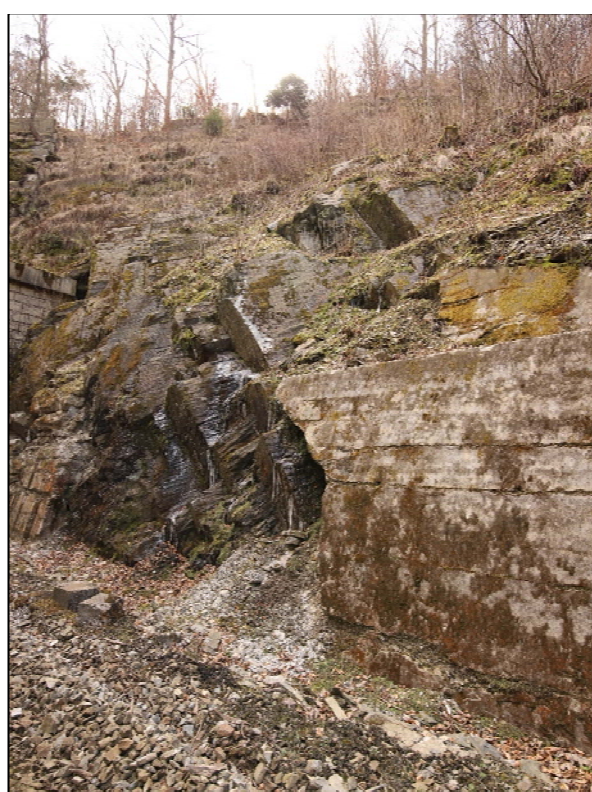
Obrázek 26: v km 23,347 – 23,351 jsou silné výrony vody z horních partií, které silně narušují skalní stěnu
