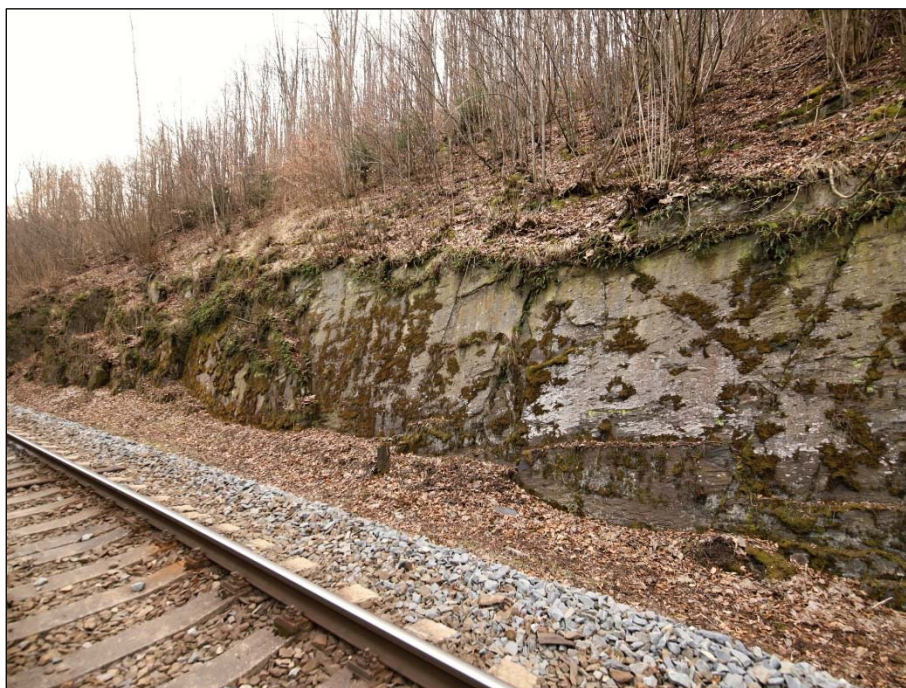
Obrázek 2: pohled na pravostrannou skalní stěnu v km 22,180- 22,220, viditelné nálety za horní hranou se zaneseným akumulacním prostorem
