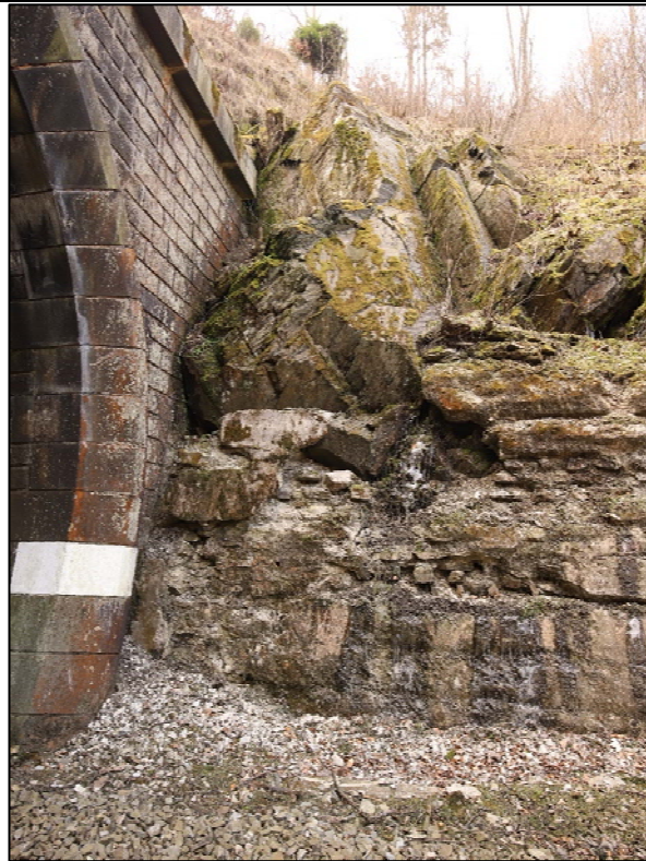
Obrázek 24: na levé straně v km 23,335 navazuje na tunel původní podezdívka která vlivem přírodních procesů neplní svůj účel, nad zídkou jsou bloky oddělené od mateřské části
