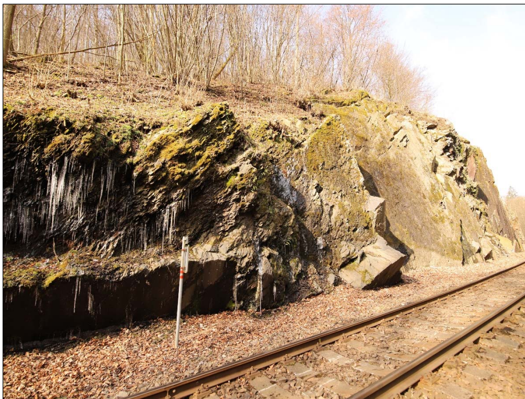
Obrázek 15: v km 22,925 se nachází ledopády, které se tvoří díky velkému množství vody, který extrémně rychle přeměňuje horninu na potenciální nebezpečné skalní řízení
