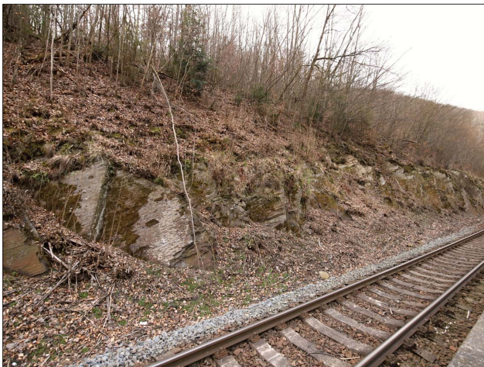
Obrázek 5: pohled na pravostranný skalní svah v km 22,260 - 22,320, skalní svah s rozvolněným materiálem, akumulací zanesený opa dawkami z vyšších partií svahu
