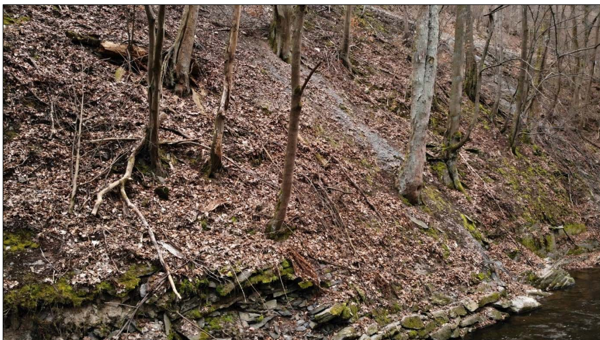
Obrázek 4: v km 22.245 zemní svah ve spodní části zakončený volně loženým kamenem
