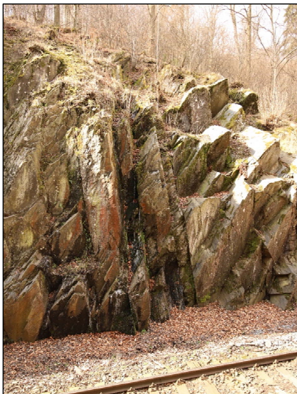
Obrázek 22: na levé straně v km 23,012 – 23,022 je u paty svahu výron vody, který protéká komunikačními spáry v masivu i po povrchu, vlivem mrazových cyklů odděluje bloky od mateřské části
