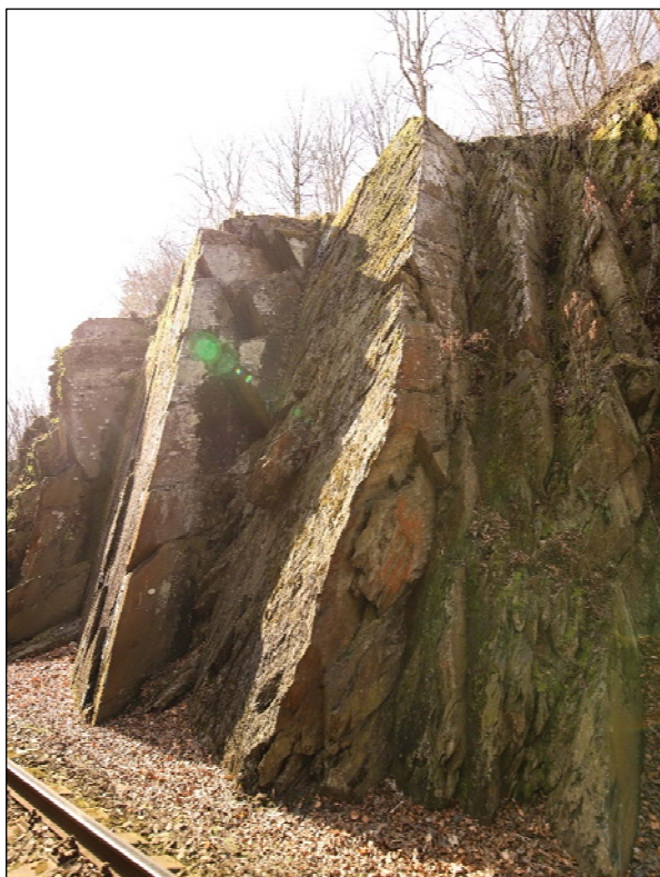
Obrázek 17: na levé straně v km 22,945 – 22,960 jsou kompaktní stěny, na kterých jsou lokálně oddělené malé bloky převážně na horní hraně skály
