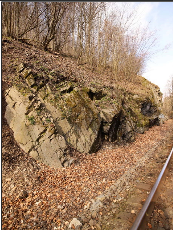
Obrázek 14: levostranný svah v km 22,870 - 22,930, skalní masiv v horní části s rozvolněným materiálem
