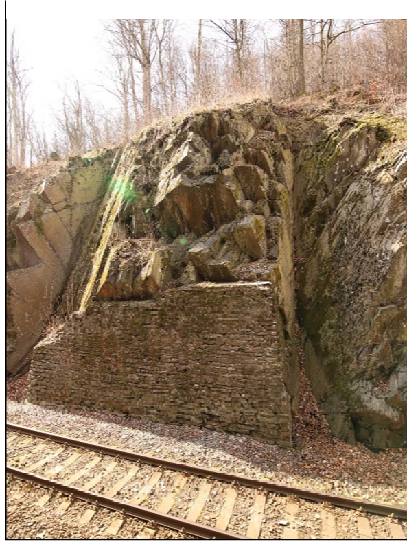
Obrázek 189: v km 23,000 – 23,020 se nachází zárubní zeď, masiv nad zídou je mírně degradovaný
