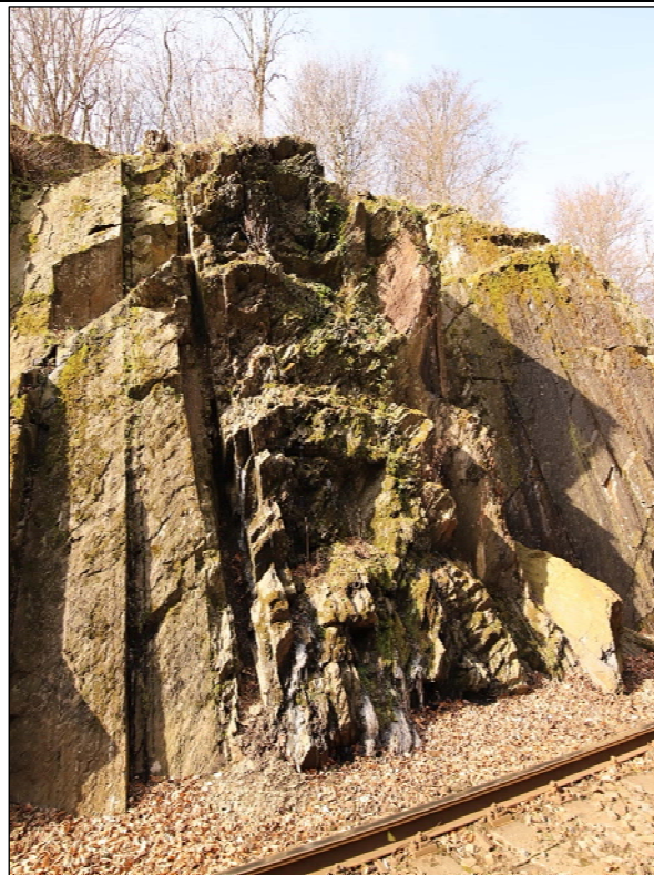
Obrázek 13: v levostranném svahu se v km 22,945 – 22,955 se nachází silně degradovaná část, která je svou geologií podléhá rychlé degradaci a tak ohrožuje rozvolněným materiálem trať
