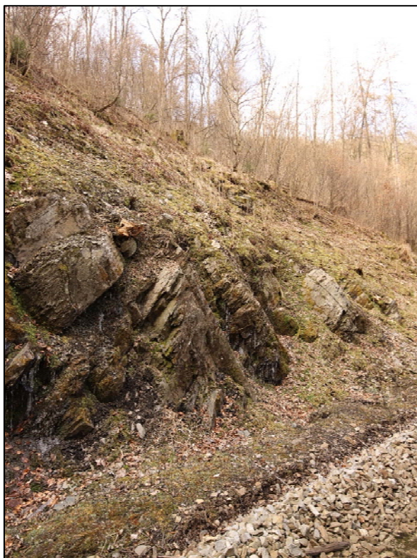
Obrázek 28: na levé straně v km 23,358 – 23,366 se nachází ve spodní části svahu degradované skalní bloky, v horních partiích je skalní výchoz překryt zeminou
