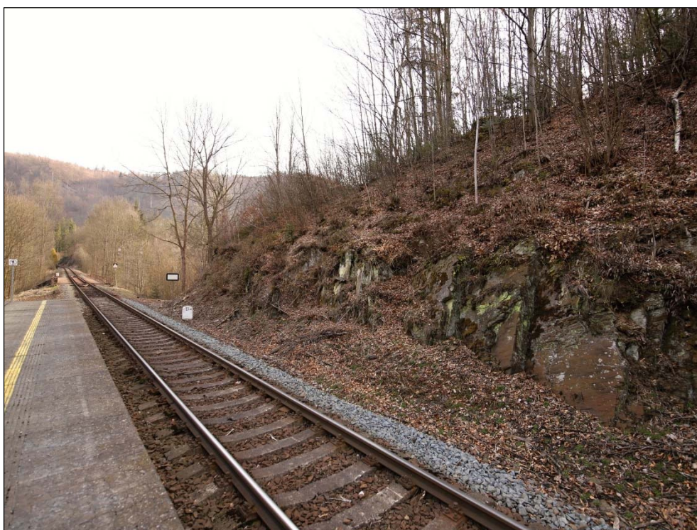
Obrázek 6: pohled na pravostranný skalní svah v km 22,360- 22,400, velmi degradovaný skalní svah vlivem srážkové vodní aktivity s kombinací mrazových cyklů
