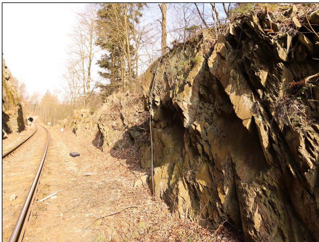
Obrázek 20: na pravé straně v km 22,955 – 23,015 je skalní svah který lokálně v horních partiích nese rozvolněný materiál který je svým charakterem značně nestabilní
