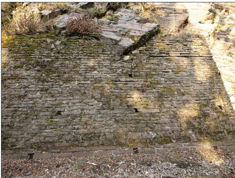
Obrázek 9: zárubní zed' na levé straně oboustranného zářezu v km 22,633- 22,647 s viditelnou narušenou horní hranou, která je vytlačována mrazovými cykly,
