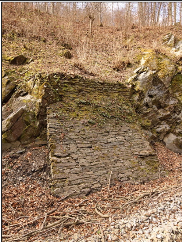
Obrázek 25: zídka před tunelem v km 23,2275, horní polovina zídky je vlivem vodní aktivity vytlačována
