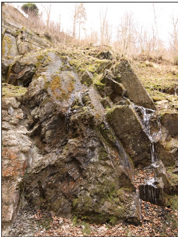
Obrázek 27: na levé straně v km 23,352 – 23,357 je podbetonovaný skalní svah za který zatéká voda z horních partií, zídka je silně narušená a hrozí vyvalení s částí degradované skály
