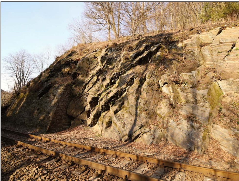
Obrázek 8: pohled na levou stranu oboustranného skalního zářezu v km 22,630- 22,665, skalní stěna nad zárubní zdi a horní část zárubní zdi je velmi degradována, na skalním masiv jsou potencionálně nestabilní části oddělené od mateřské části, v akumulčním prostoru je napadáný drobný materiál do velikosti fotbalového míče
