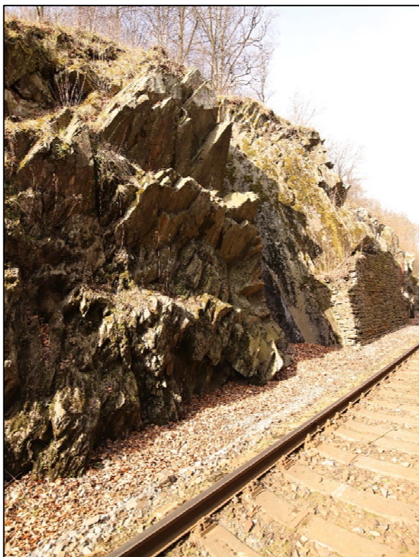
Obrázek 198: v km 22,970 – 23,000 jsou skalní výchozy, které jsou uloženy na spodní části masivu který degraduje rychleji než vrchní kompaktní část
