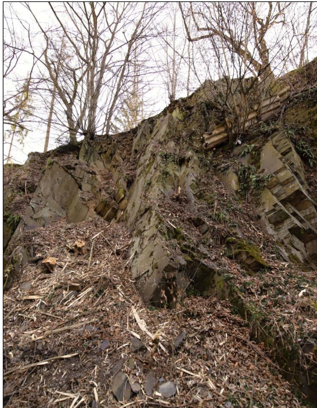
Obrázek 12: pravá strana oboustranného zářezu v km 22,610 - 22,625, kde se v horní partii nachází rozvolněný skalní materiál oddělený od zdravé části masivu
