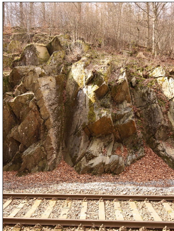
Obrázek 21: na levé straně v km 23,025 – 23,035 se nachází mírně degradovaný masiv kde v horních partiích jsou vlivem povětrnostních vlivů rozvolněné části masivu
