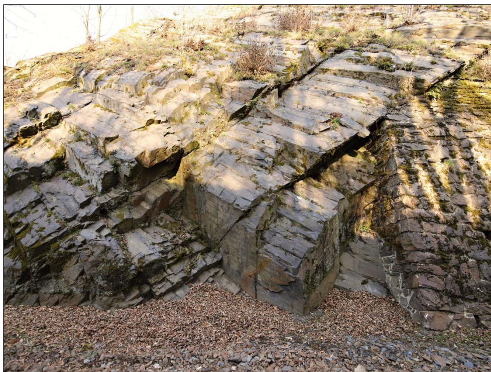
Obrázek 10: skalní masiv navazující na zárubní zed' v km 22,633, skalní masiv s rozvolněnými bloky, které jsou odděleny od mateřské části
