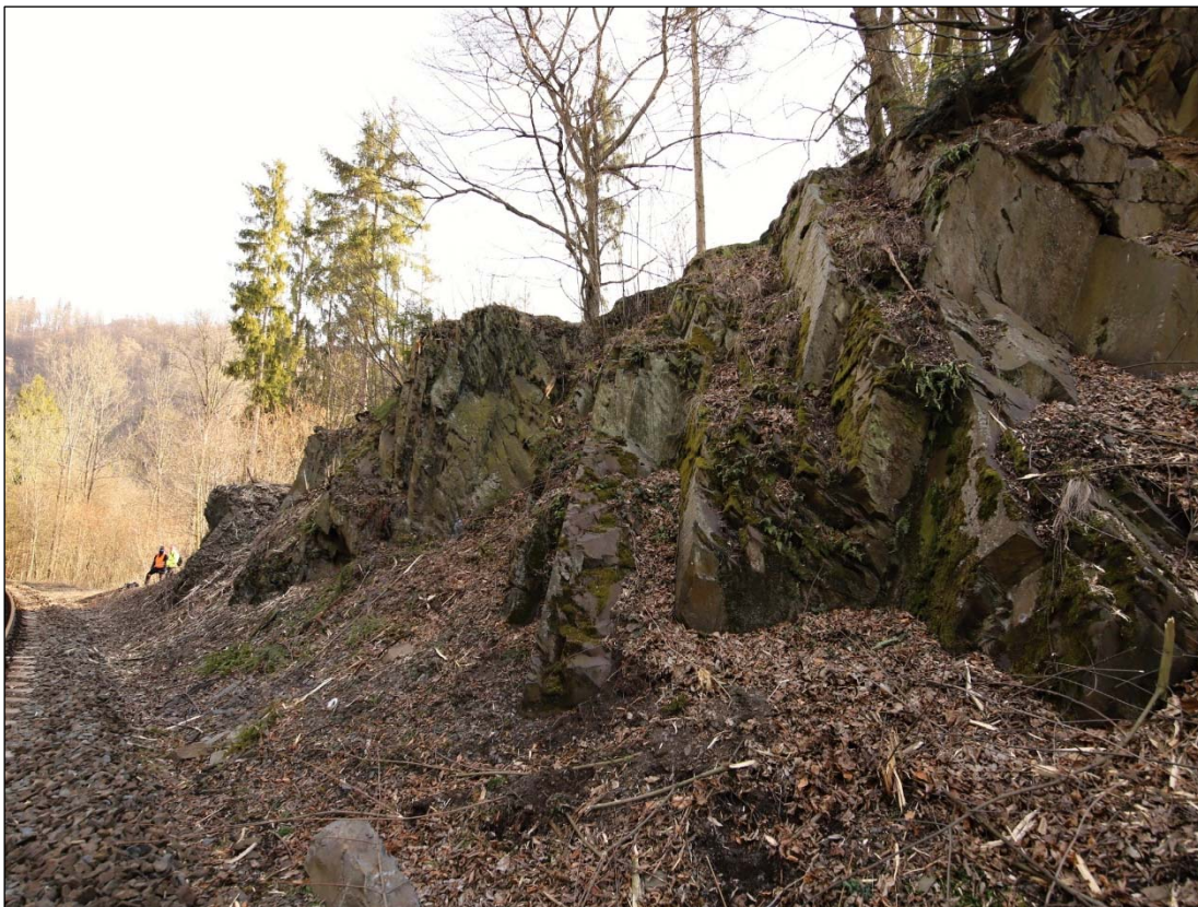
Obrázek 11: pravá strana oboustranného zářezu v km 22,630 – 22,665, velmi degradované části skalní masivu, v akumulacním prostoru viditelný opad o velikosti čtyř fotbalových míčů
