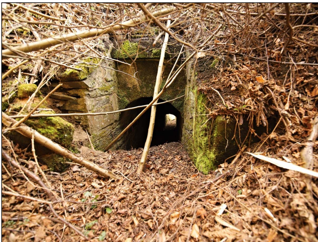
Obrázek 23: na levé straně v km 22,744 je funkční stávající propustek
